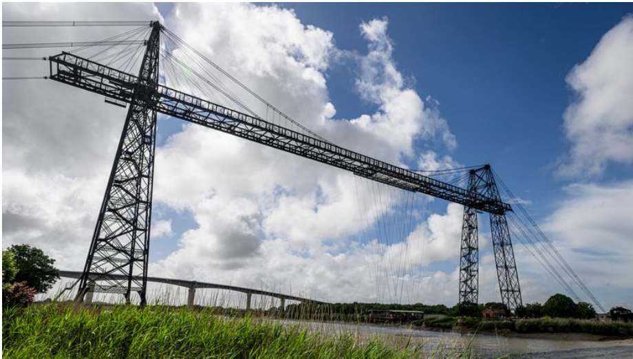
Pont transbordeur (Echillé)
